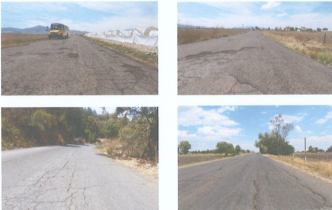
Figura 6. Deterioro en la superficie de rodamiento en las carreteras estatales MICH-03 y MICH-35 Epitacio Huerta – Tlalpujahua y La Cinta – Santa Ana Maya
