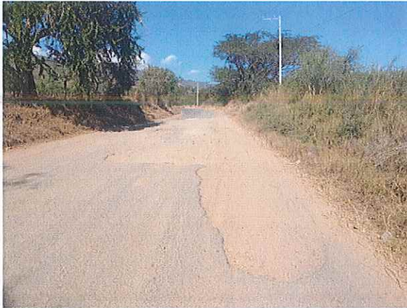
Figura 6. Deterioro en la superficie de rodadura en la carretera Aguililla – Dos Aguas
