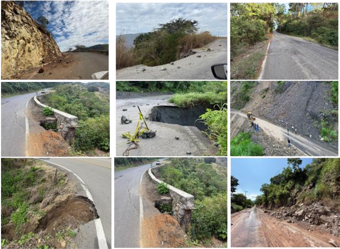
Figura 15. Carretera estatal MICH-29, en su tramo Tepalcatepec – Coalcoman - Aquila.
