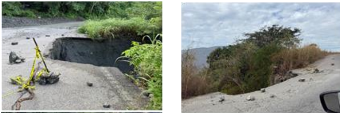
Figura 6. Deterioro en la superficie de rodamiento en la carretera estatal MICH-29, en su tramo Tepalcatepec – Coalcoman – Aquila
