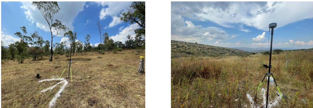
Figura 7. Construcción del nuevo camino del Segmento 5
