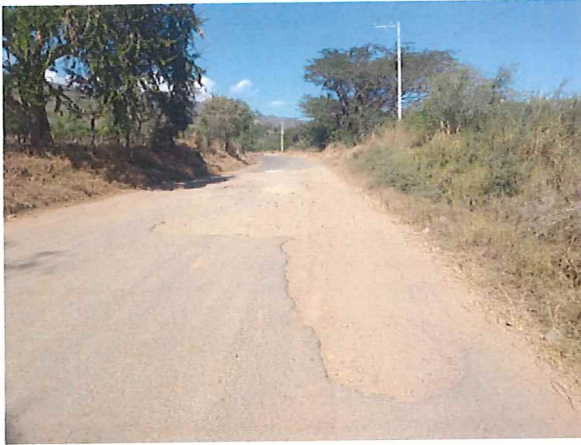
Figura 6. Deterioro en la superficie de rodamiento en la carretera Aguililla – Dos Aguas
