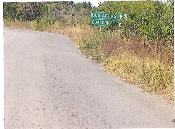
Figura 6. Deterioro en la superficie de rodamiento en la carretera Aguililla – Dos Aguas
